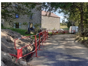
Les travaux chemin de l'Hort
