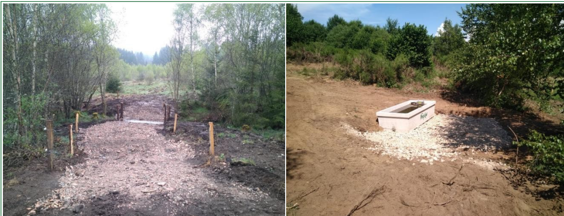
Aménagement de dispositifs de franchissement et d'abreuvoirs © S. Rigaud, SMPNRLF
